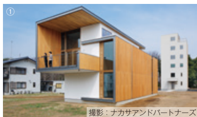
①「CoCo(ココ)CLT」(CLTつくば実験棟)茨城県つくば市の(国研)建築研究所の敷地内。延床面積166㎡・2階建。6mの通し壁による吹き抜けや、3mバルコニーは床板をオーバーハングするなどCLTの特徴を生かした空間
