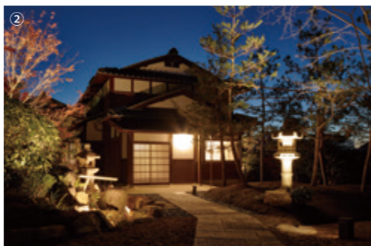
仁和寺の宿坊「松林庵」。① 2階の茶室。丸太の柱や土壁、杉板の天井など、すべてをそのまま生かしている。② 外壁の板張り、杉皮を細竹で押さえた壁など、従来の意匠を再現
